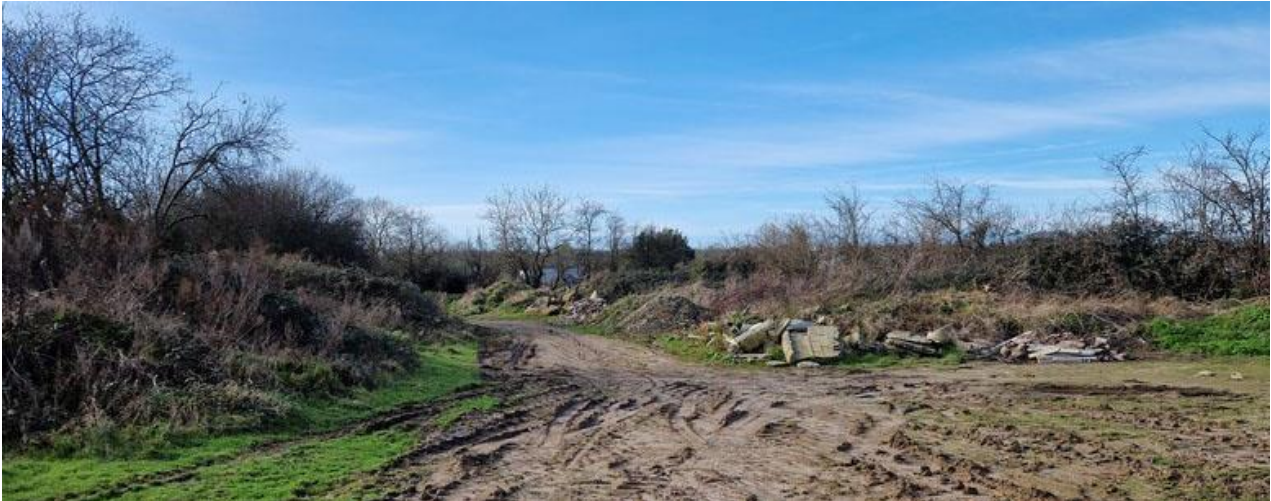
Aspect de la zone de dépôt avant travaux
