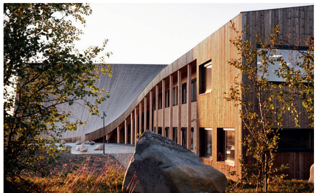
Exemple de façade Shed - Maroquinerie de la Sormonne - Coldefy
