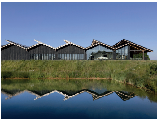
Exemple de façade Shed - Maroquinerie de la Sormonne - Coldefy
